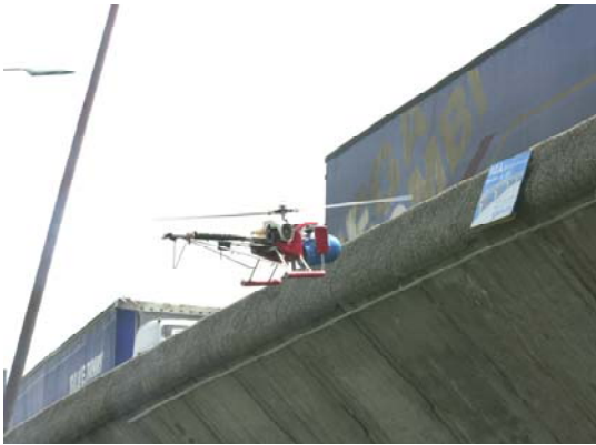
Figure 11 : Hélicoptère près de l'ouvrage
