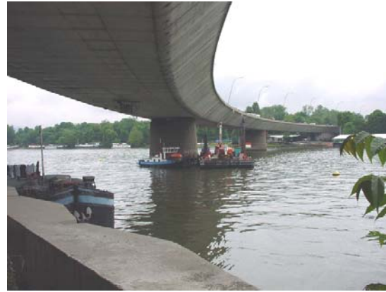
Figure 6 : Vue d'ensemble du viaduc
